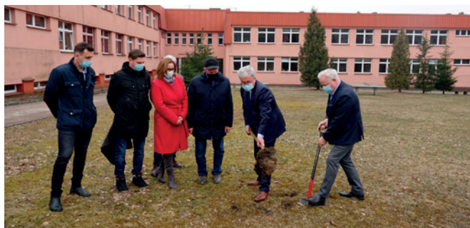
Symboliczne wkopanie łopaty przez Wójta Gminy Klucze Norberta Bienia oraz Wiceministra Sportu i Turystyki Jacka Osucha pod budowę hali sportowej przy SP Klucze
